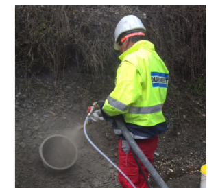
Applizieren von Spritzbeton
