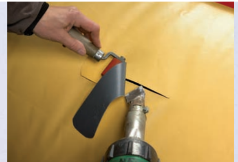
Reparatur durch Schweißen
